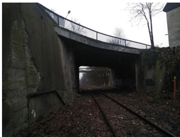
Abbildung 20: Foto Brücke Bielefelder Straße 117
